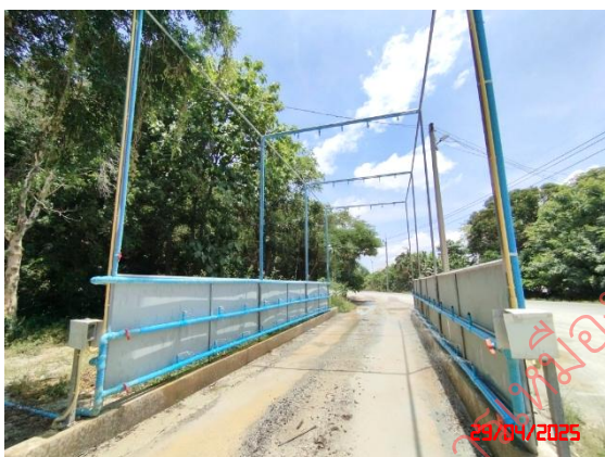
รูปที่ 11 ระบบล้างล้อรถบรรทุก
